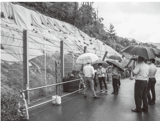
工事箇所を入念に視察する委員(生守)
