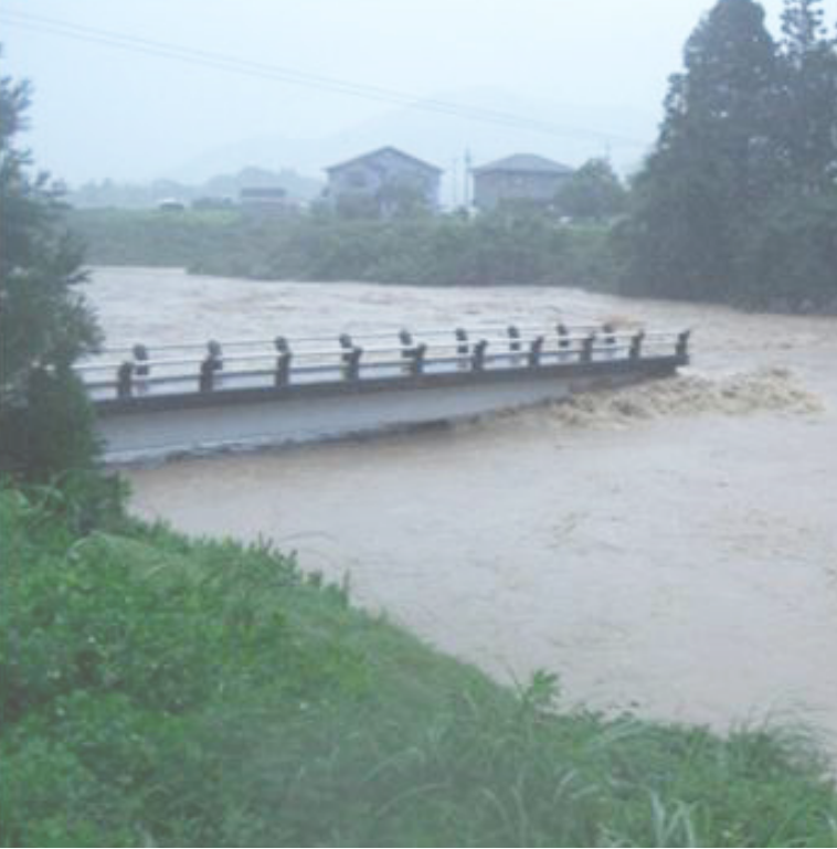
▲飛川橋流失（平成 25 年・下中井）
