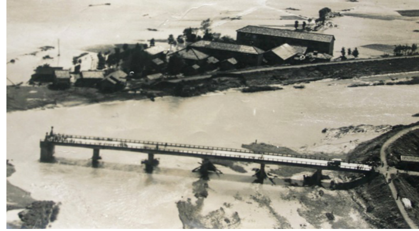
昭和 28 年台風 13 号で発生した豪雨災害(湯岡橋)
