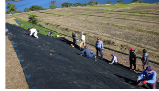
▲環境保全のため、組合員らが法面に防草シートを張る様子
