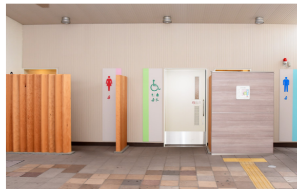
■改修後の「J R小浜駅」のトイレ
