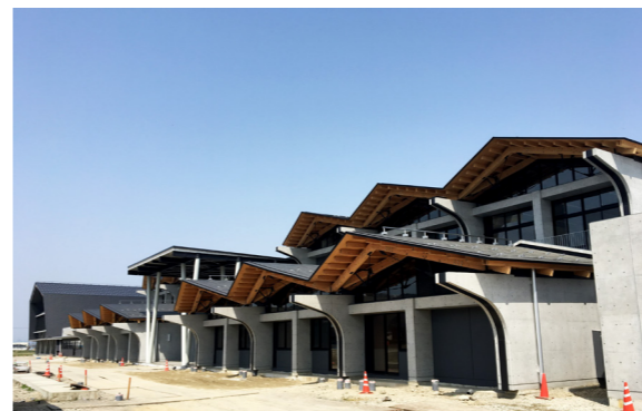
■建設中の「小浜美郷小学校」校舎正面
