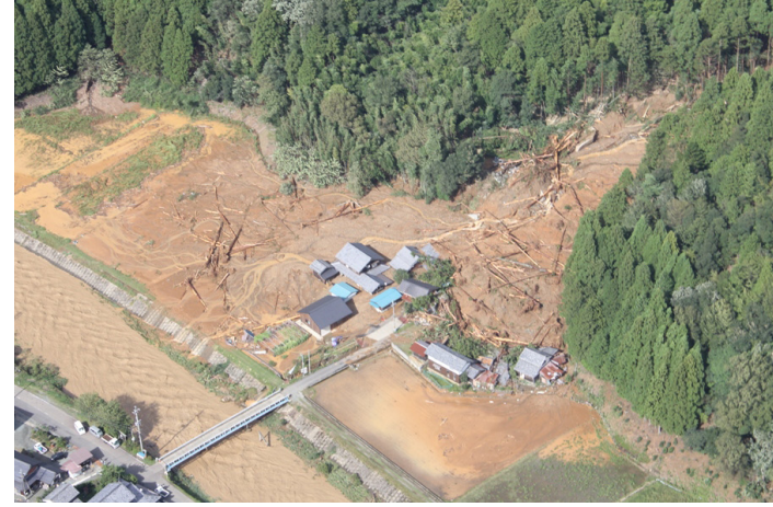
平成 25 年台風 18 号で発生した土砂災害（忠野）
