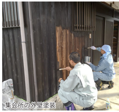
集会所の外壁塗装
