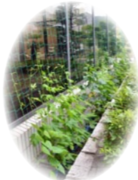
庁舎に設置されたグリーンカーテン
