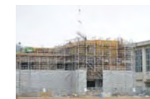
【改築中の小浜中学校北館】
