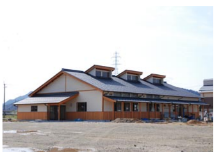
工事が進む複合型活性化施設（3月10日）
