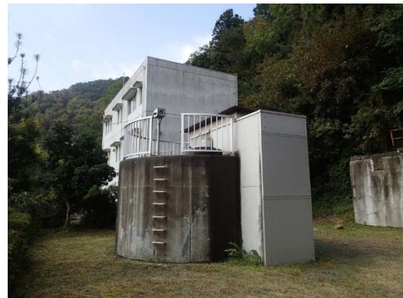
湯岡水源 小浜市上水道のもっとも主要な水源井戸で、南川沿いの浅い地下水を毎日汲み上げています。
