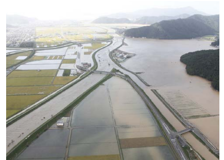
野木川決壊(平成25年台風18号)
