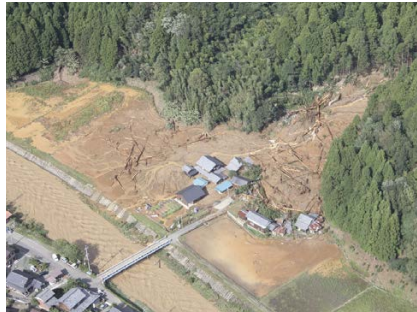
忠野区 土砂災害(平成25年台風18号)
