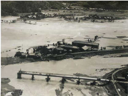
湯岡橋 南川氾濫(昭和28年台風13号)
