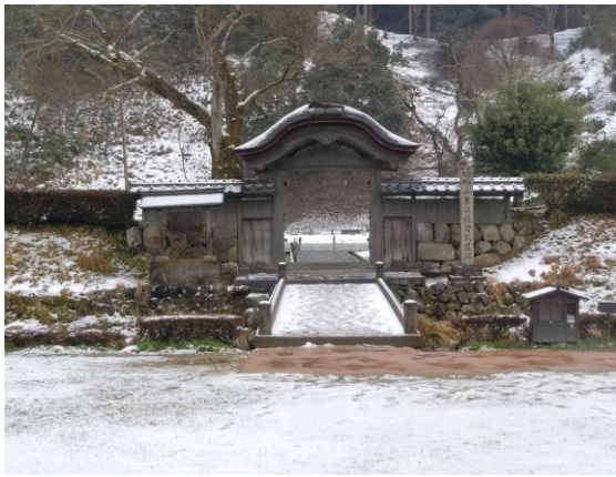
朝倉館 門遺構
