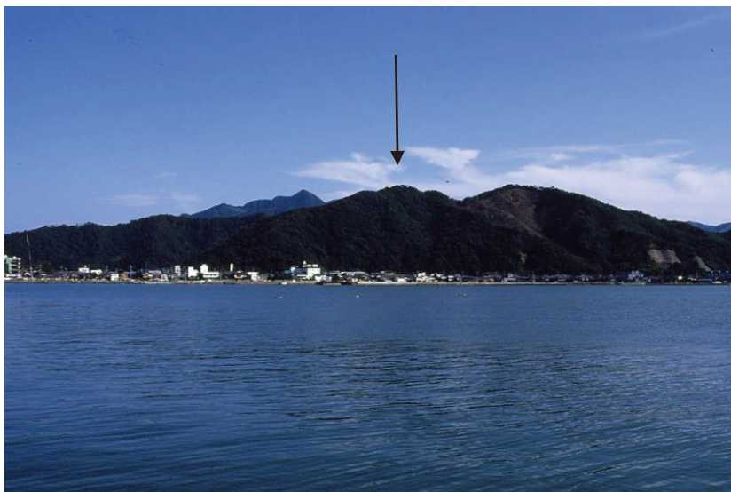
第28図 史跡後瀬山城跡遠景 (矢印は後瀬山城跡)
